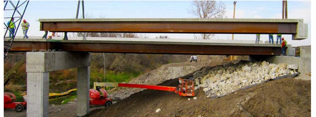
些技术将在制造和施工中提供规模经济，减少交通中断并提高安全性。预制桥梁构件已在许多州使用，但迄今为止，**每种设计都是独特的，需要高水平的工程和施工监督。**
